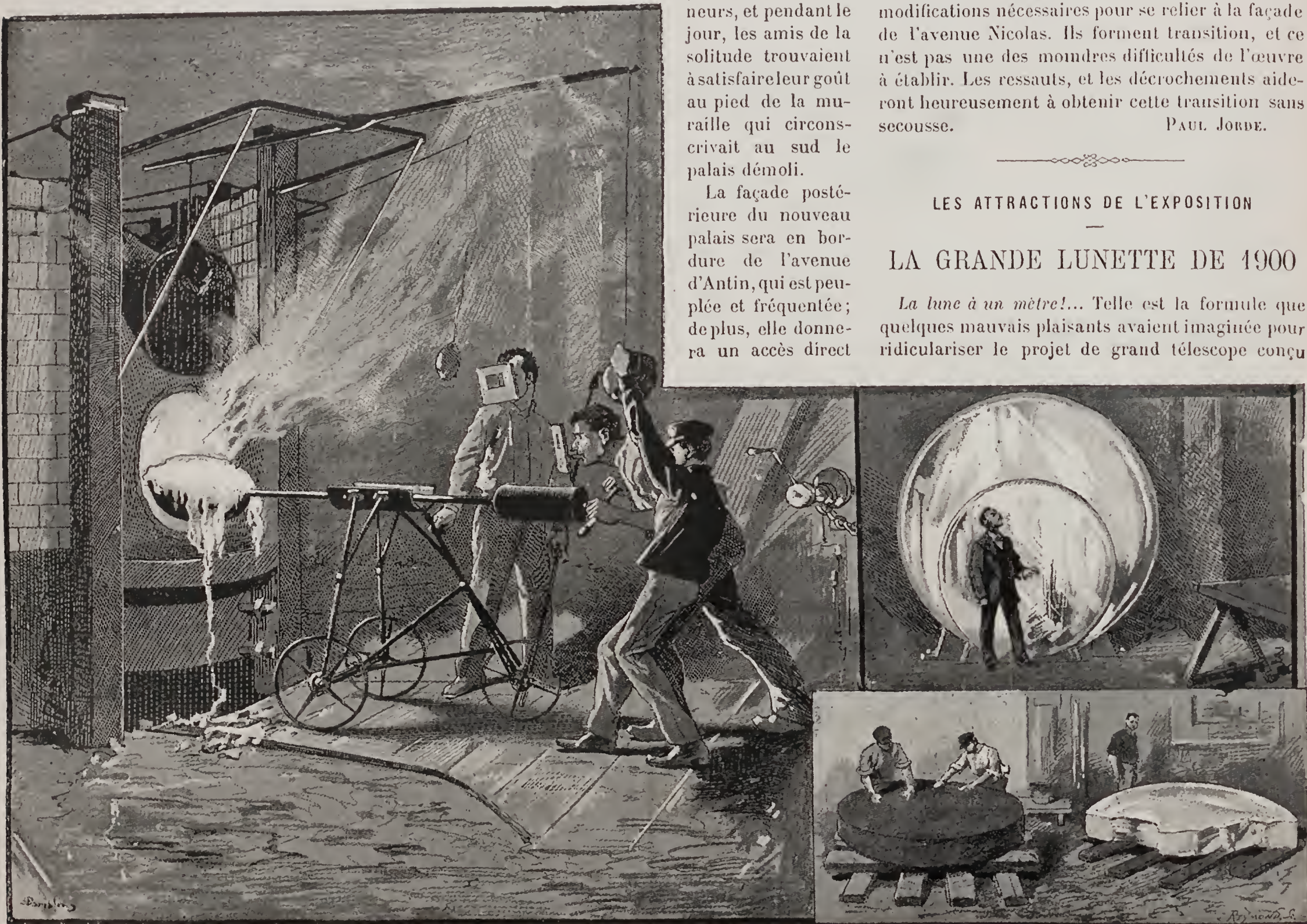
LA GRANDE LUNETTE DE 1900. — 1. Ouverture d'un four et manœuvre de la poche. — 2. Dimensions comparatives d'un miroir de 2 mètres de diamètre et d'un autre de 3 mètres. — 3. Un miroir brut, un autre brisé.
